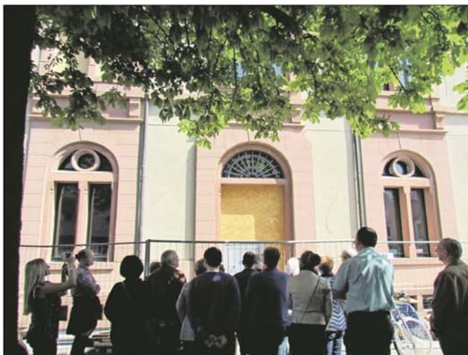
Der frühere Seiteneingang des Rathauses I wird wiederhergestellt.
